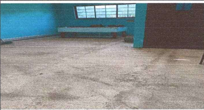
Foto 3: Sustitución de piso por piso cerámico de cocina.
