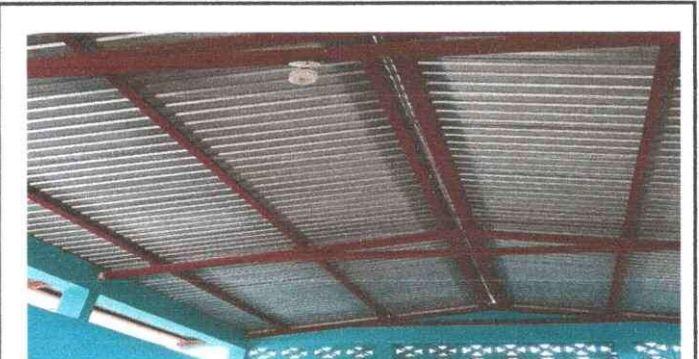
Foto 6: Sustitución de cableado y reinstalación de la misma.
