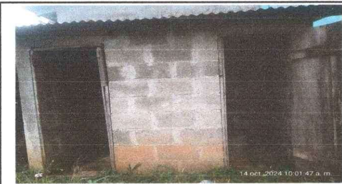
Foto 5 Reparación de letrina o baño por Fósfa septica.
